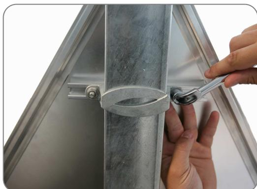
Une seule personne suffit pour monter le panneau sur son support sans difficulté. Utiliser une clef de 13 pour serrer l'écrou.
